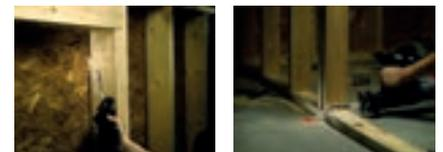
Coupe au ras – butée de garde préservant l'affûtage lors des coupes au ras de murs, des planchers.
